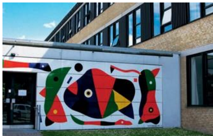
81 Danmarks Tekniske Universitet, Bygning 304
