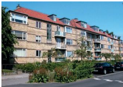
50 Pipers Park, Ulrikkenborg Allé
