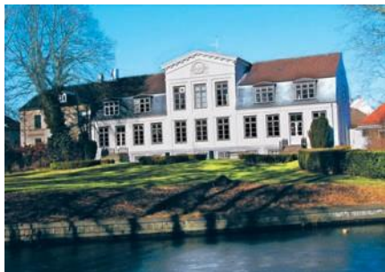
19 Gammel Rustenborg, Rustenborgvej 3
