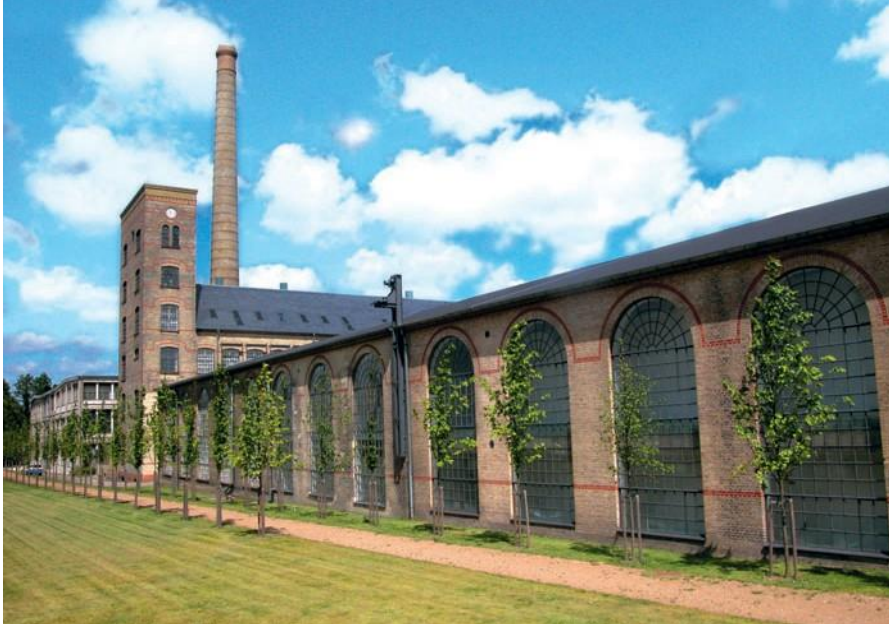
29 Brede fabriksbygning, I.C. Modewegs Vej
