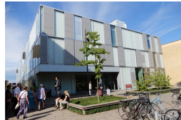
DTU, bygning 324, 2011-13, arkitekt Christensen & Co, præmieret i 2015 i kategorien Nybyggeri.
