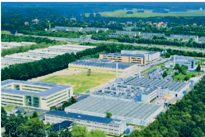
Luftfoto af fabriksområdet mellem Lundtoftevej og Lundtoftegårdsvej
