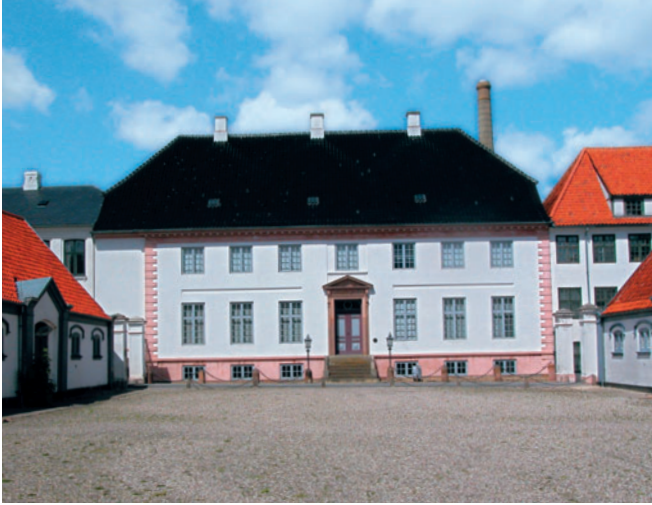
Brede Værks hovedbygning på I. C. Modewegs Vej
