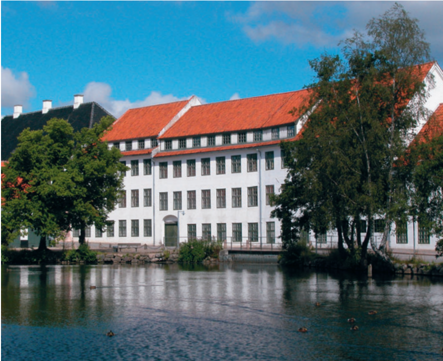
Brede Værk set fra Brede Dam
