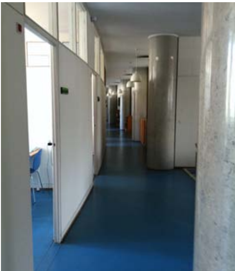
Foto fra kontorgang, der viser de lette skillevægge. Princippet med de lette vægge var i fuld overensstemmelse med Langkilde og Ib Martin Jensens hensigt, at bygningen skulle kunne forandres dynamisk indvendigt.
