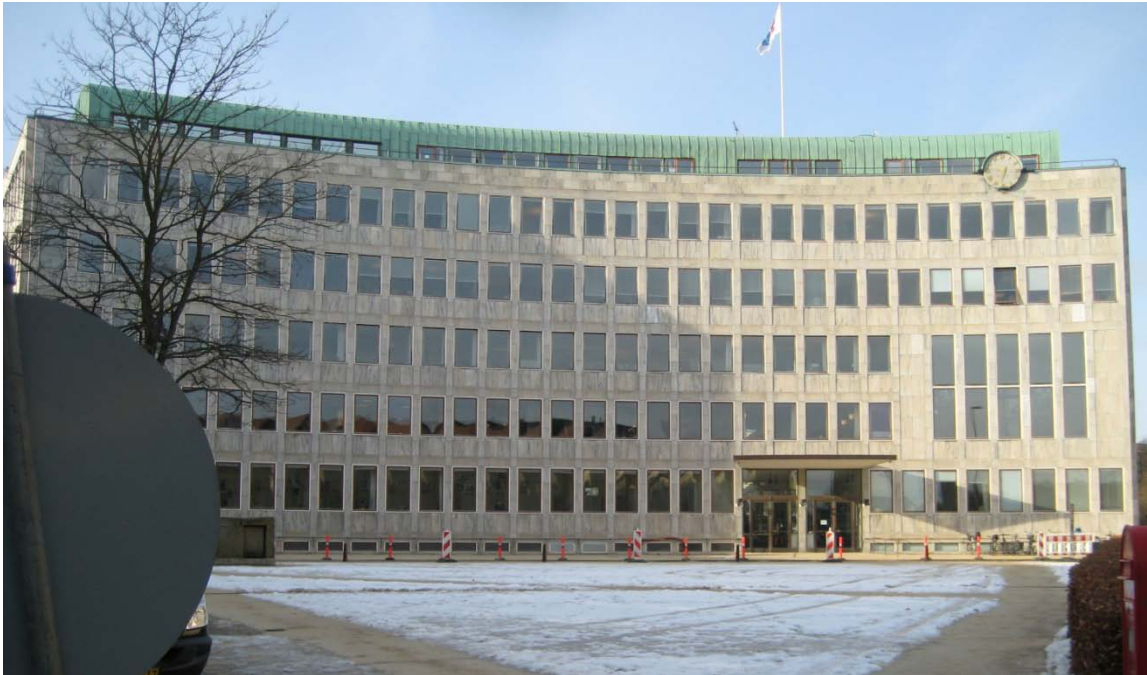
Rådhusbygningen i 2013. Hovedindgang og rådssal med den dobbelthøje etage ses i billedets højre side. Rådssalen var i arkitektforslaget foreslået i bygningens venstre side. Bemærk det funktionalistiske ur placeret øverst i højre side.
