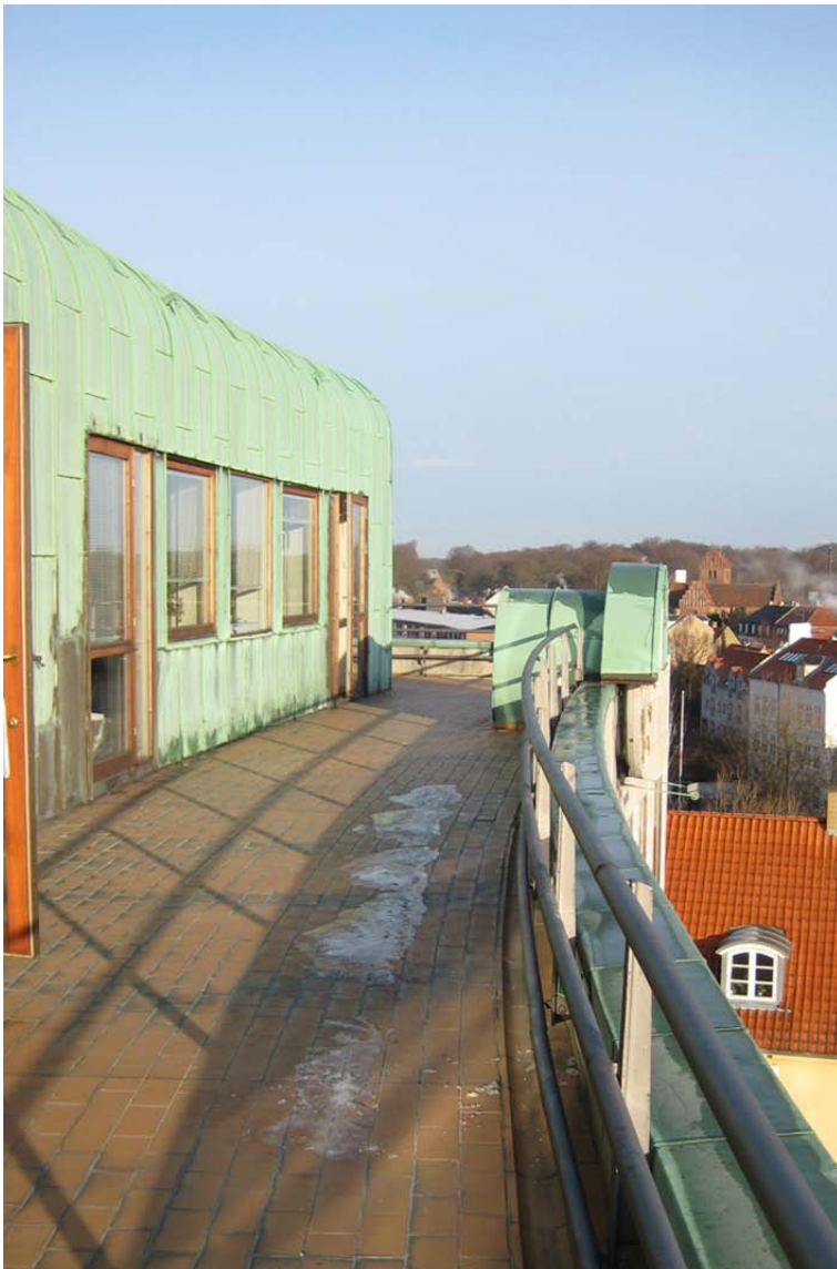
Tagterrassen – vue mod nord. Bemærk brystningsparti og de originale døre/vinduespartier og dækket, der er klinkebelagt.
