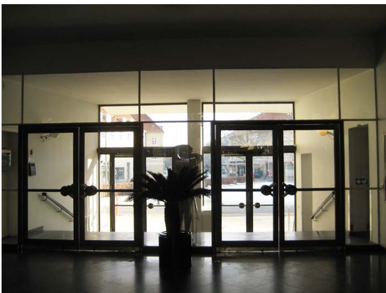
Fra rådshushall ud mod Lyngby Torv. Bemærk at døre er i glas, bevaret i det for tiden karakteristiske formsprog.
